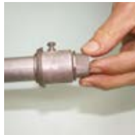
Glide the joint sealing for conduit until cover up the connector. Deslizar la junta de vedación para el electroducto hasta cubrir el conector.
